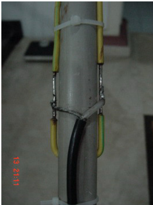
J-Pole dari kabel NYY siap digunakan
